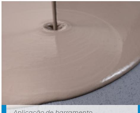
Aplicação de barramento autonivelante sobre Eco Prim Grip Plus seco e aplicado sobre pavimento velho
