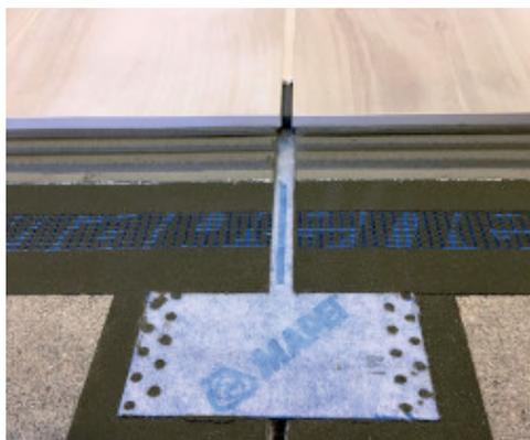
Mapeband Easy aplicado numa junta de controlo na betonilha
